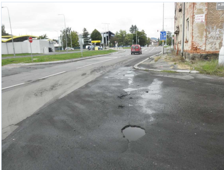
Obr. č. 2: Město Šumperk – ulice Žerotínova – 0,420 km proti směru staničení – silnice III/3703 nevyhovující stav obrubníků, přídlažby a zpevněné krajnice, výtluky v ohrubné vrstvě vozovky
