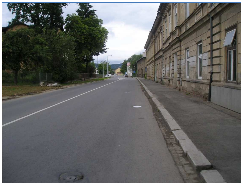
Obr. č. 1: Město Šumperk – ulice Žerotínova – 0,030 km ve směru staničení - nevyhovující stav obrubníků, přídlažby a zpevněné krajnice, umístění poklopů inženýrských sítí, uliční vpusti – silnice III/36916
