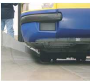
Skupina obr. 2 Prefabrikovaný betonový bezbariérový obrubník
